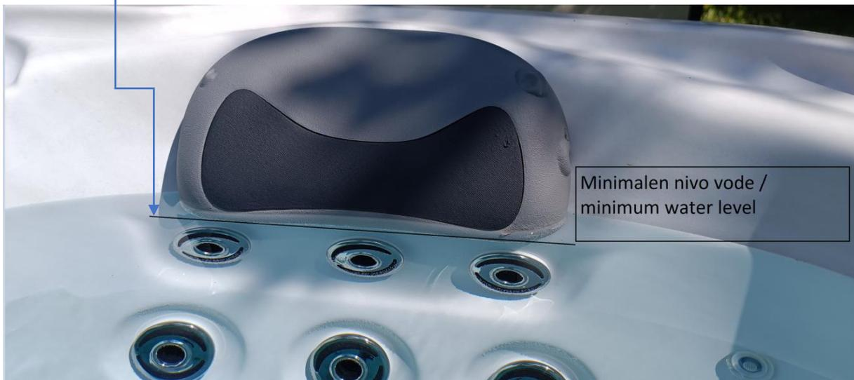
V kolikor nivo vode pade pod vzglavnik ga napolnite, vzemite cev in dotočite. V nasprotnem primeru se bo vodna črpalka skurila in uničila. Popravilo vam bomo zaračunali.
